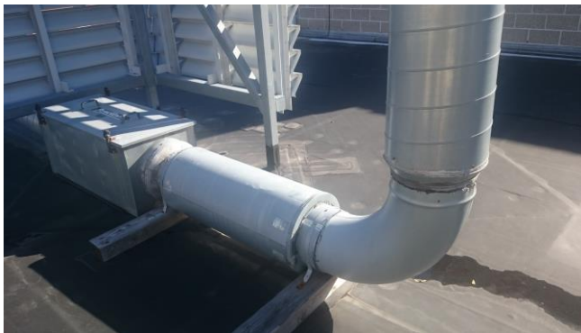
Apparatus Bay Plymovent
